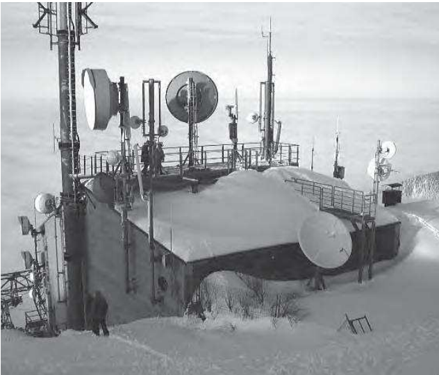
Per Richtfunk gelangt das komro Signal für Internet und Telefonie von der Hochries zur Gemeinde Engelsberg. Foto: komro
